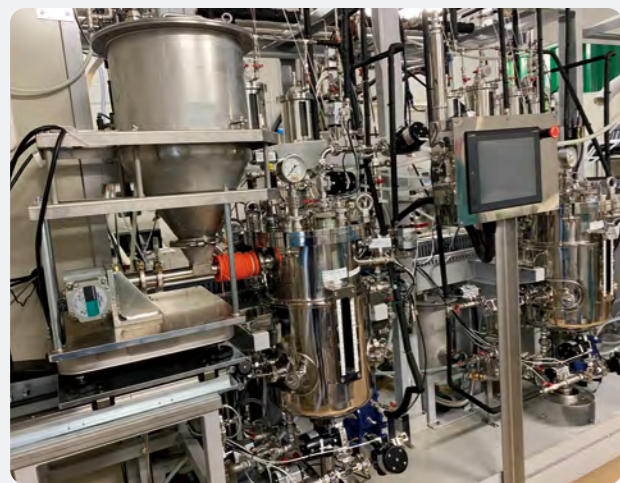
〈ベンチテストプラント機〉 Green Earth Institute株式会社のGreen Earth 研究所(木更津市)にて、2025年3月よりベンチスケール設備が稼働。(写真提供元:Green Earth Institute株式会社) バイオエタノール製造時のエネルギー消費量は、紙製品製造時と比較し、約40%抑制可能(当社試算)
