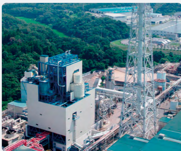
いわき大王製紙 4号バイオマスボイラー
