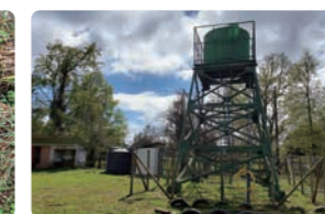
ロス・リスコス地区の学校敷地内に設置された貯水タンク(2基)
