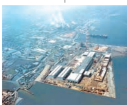
三島新工場建設
