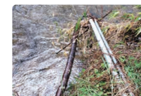
ピクトラウエ川の取水口
