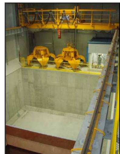
バイオマス原料建屋
