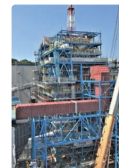
いわき大王製紙で建設中のリサイクルボイラー
