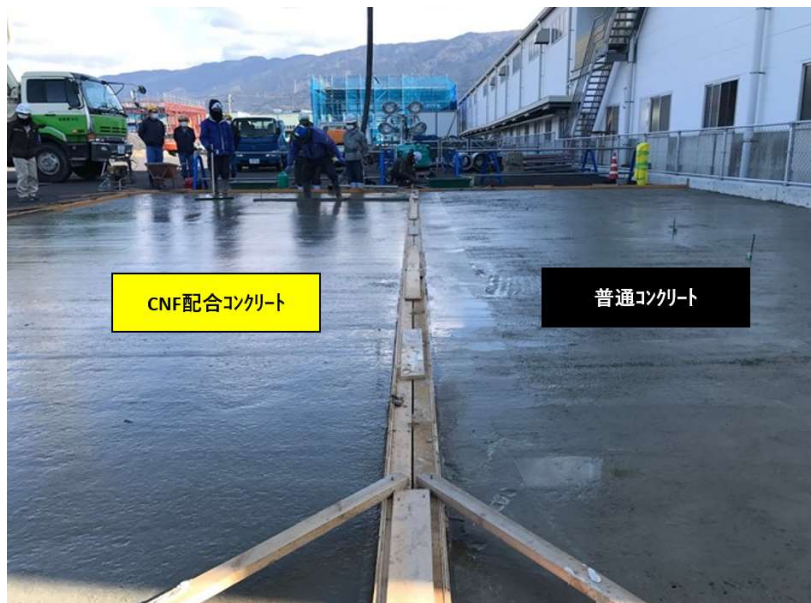
CNF 配合コンクリート施工状況
